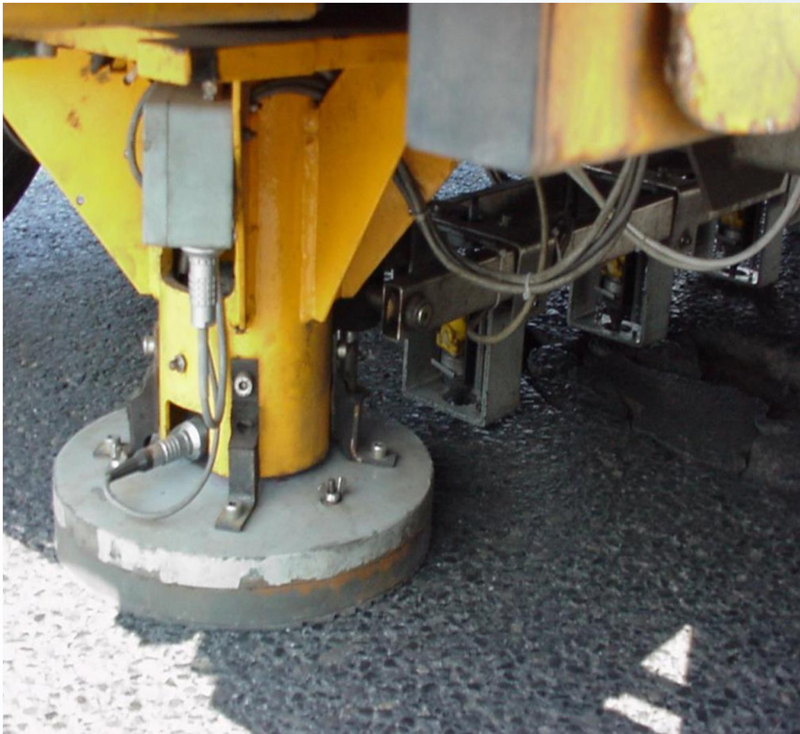
Rys.5. Pomiar ugięć przy użyciu ugięciomierza dynamicznego FWD
