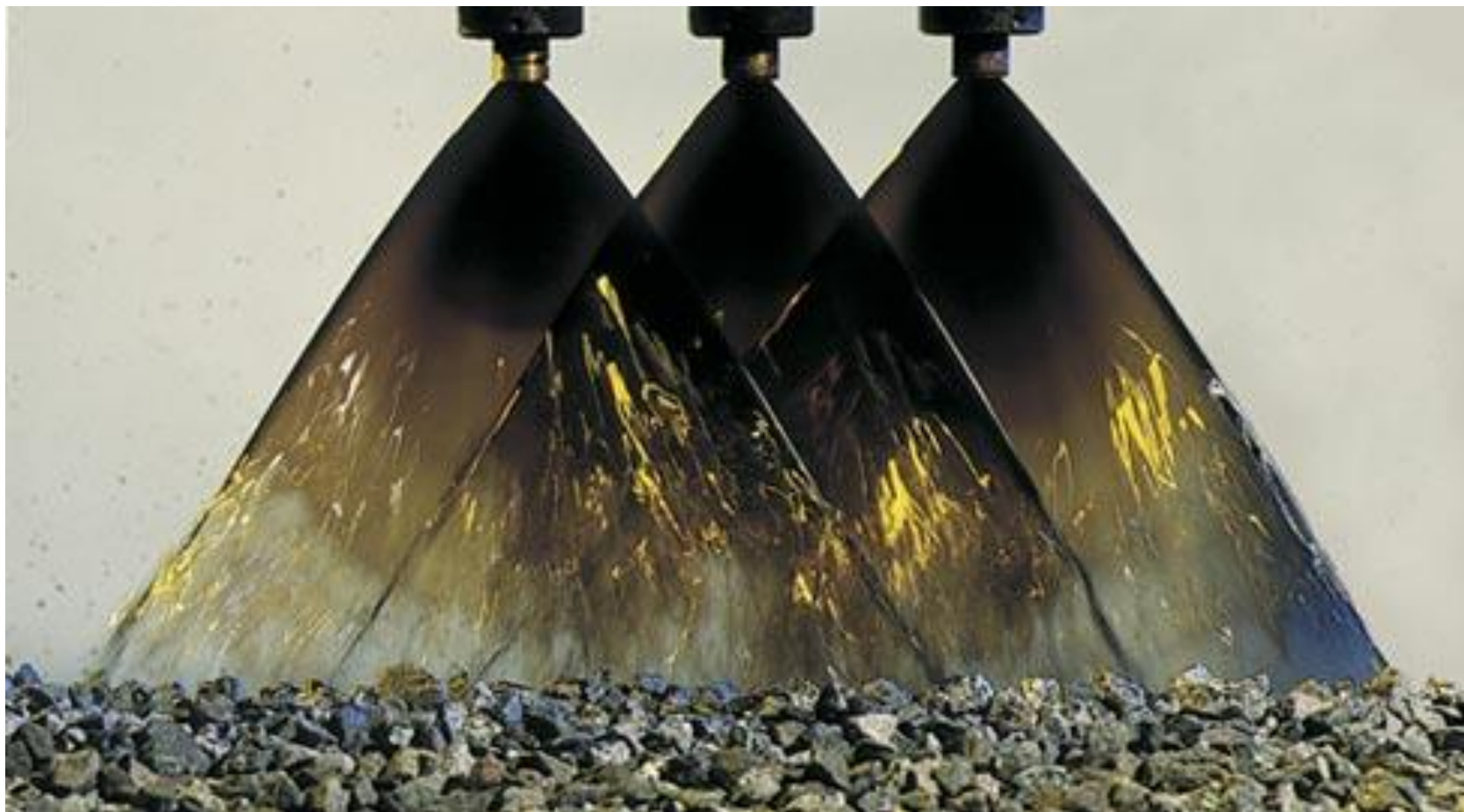
Rys. 31. Spryskiwanie warstwy nawierzchni drogowej emulsją asfaltową
