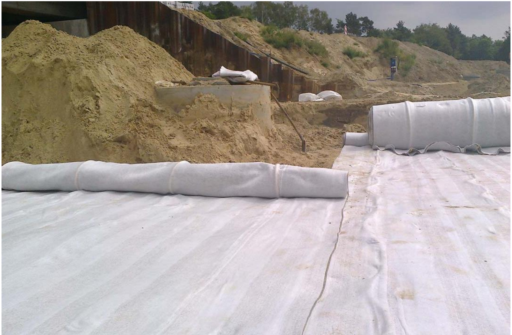
Rys. 40. Geokompozyt drenażowy
