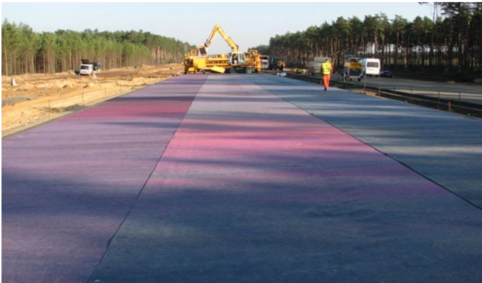
Rys. 45. Przykrycie nawierzchni betonowej geowłókniną (zabieg pielęgnacji betonu – ochrona przed nadmierną hydratacją)
