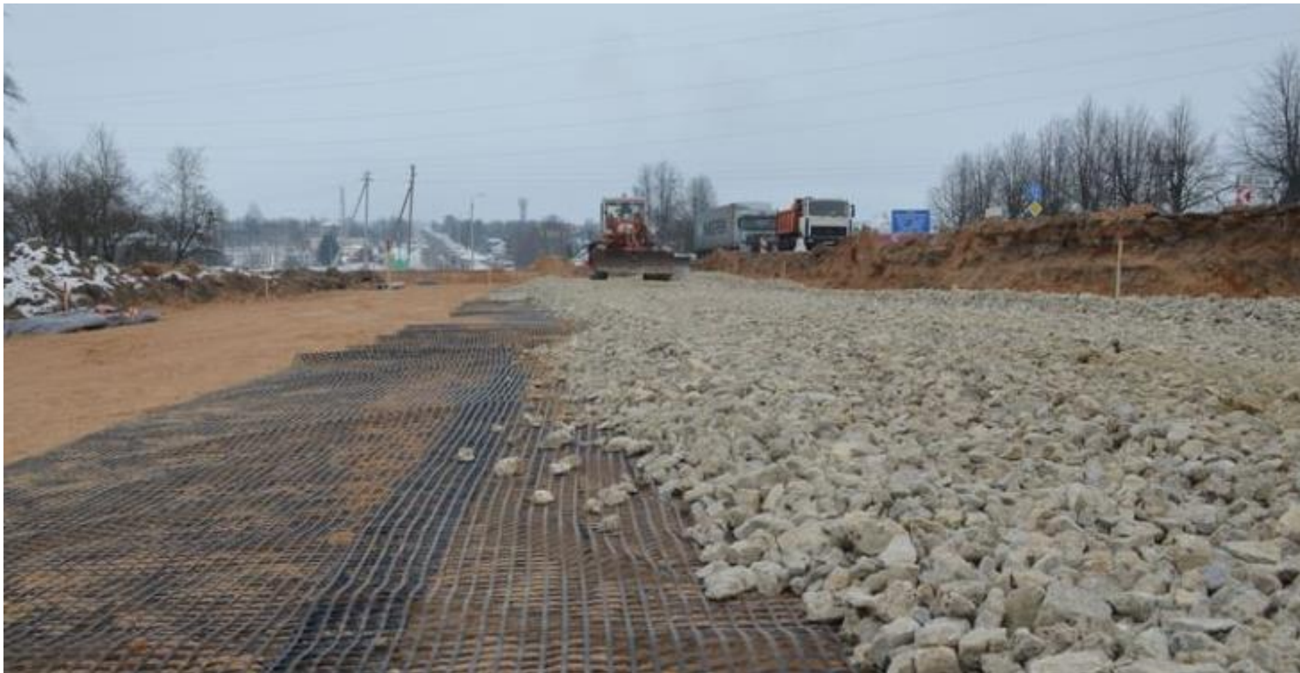
Rys. 42. Zastosowanie geosiatki w podłożu gruntowym
