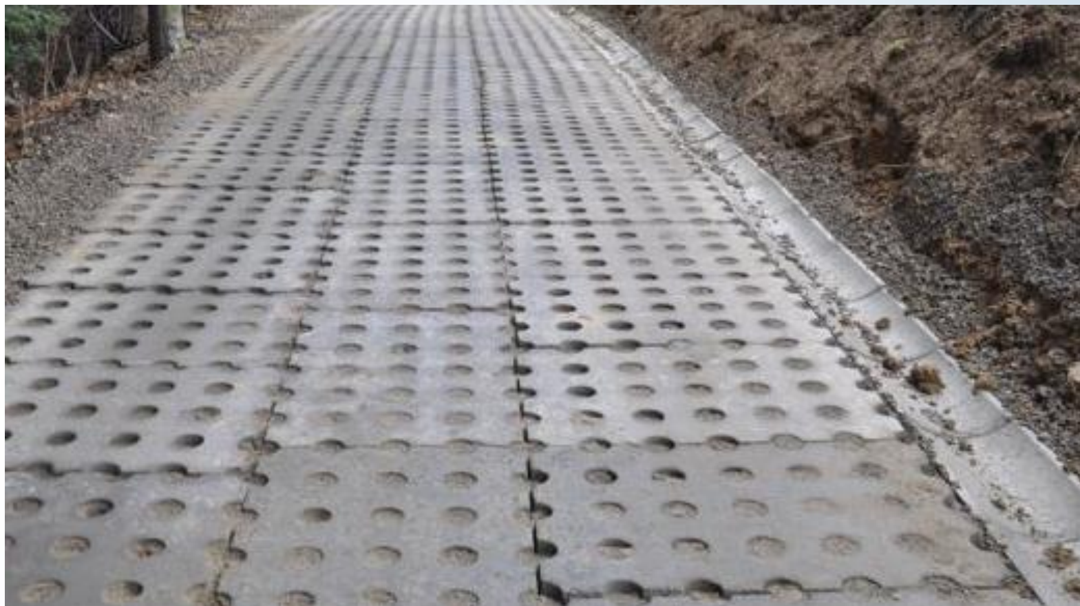
Rys. 22. Nawierzchnia z płyt ażurowych
