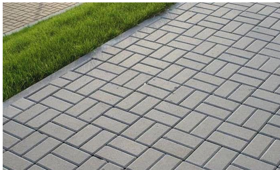
Rys. 25. Nawierzchnie z betonowej kostki brukowej
