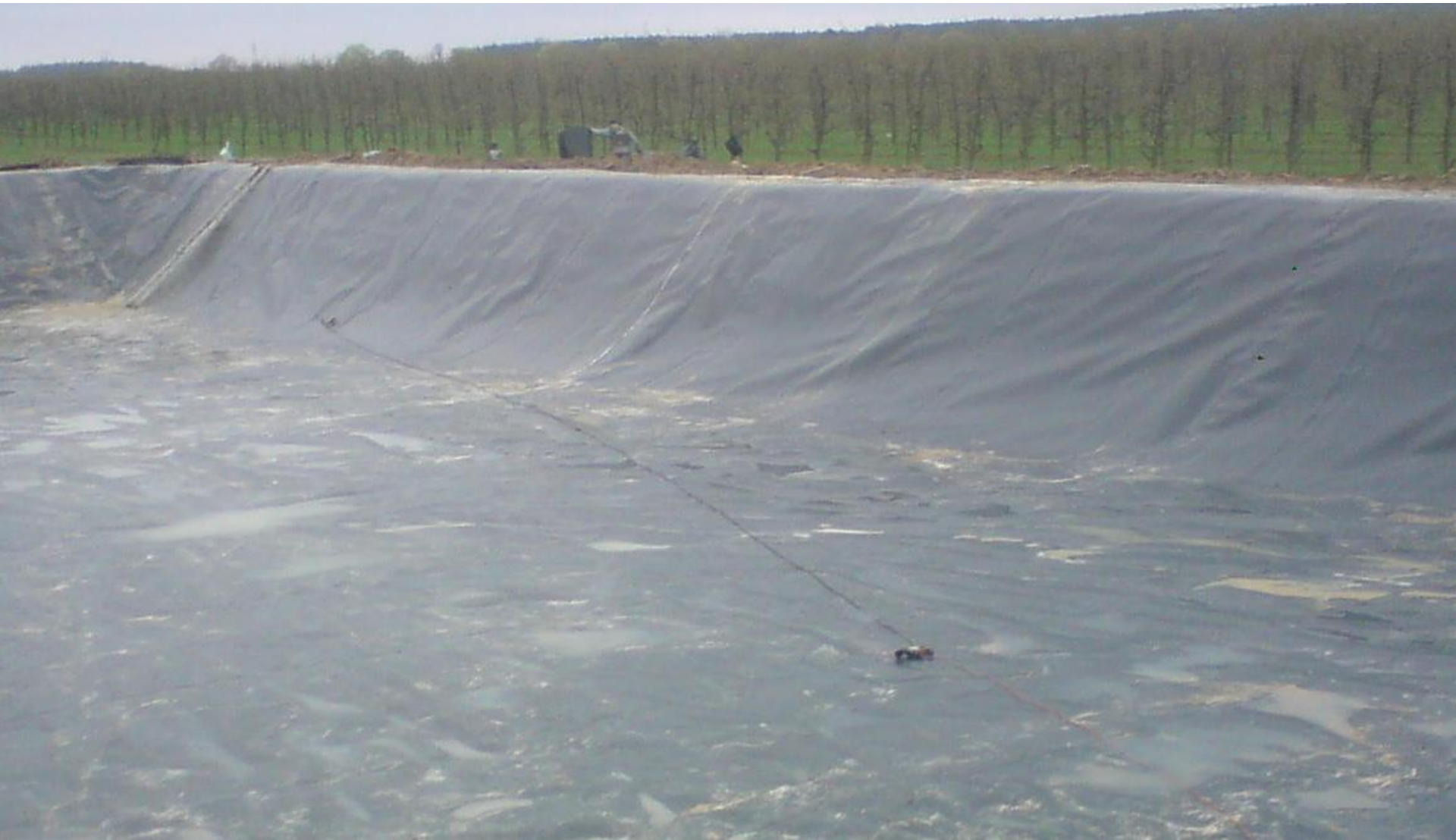
Rys. 43. Geomembrana (hydroizolacja zbiornika wodnego)
