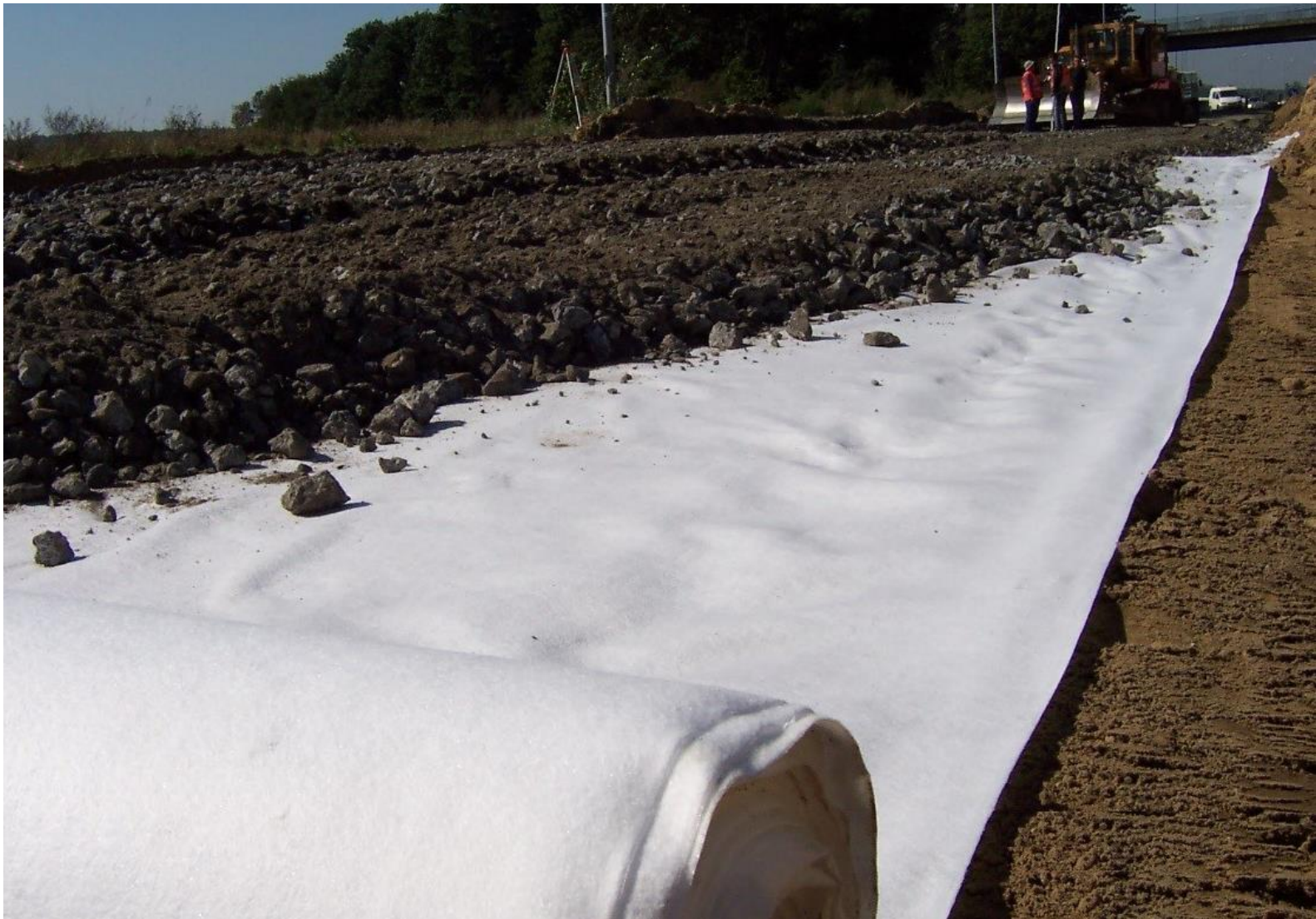
Rys. 39. Geowłóknina filtracyjno – separacyjna
