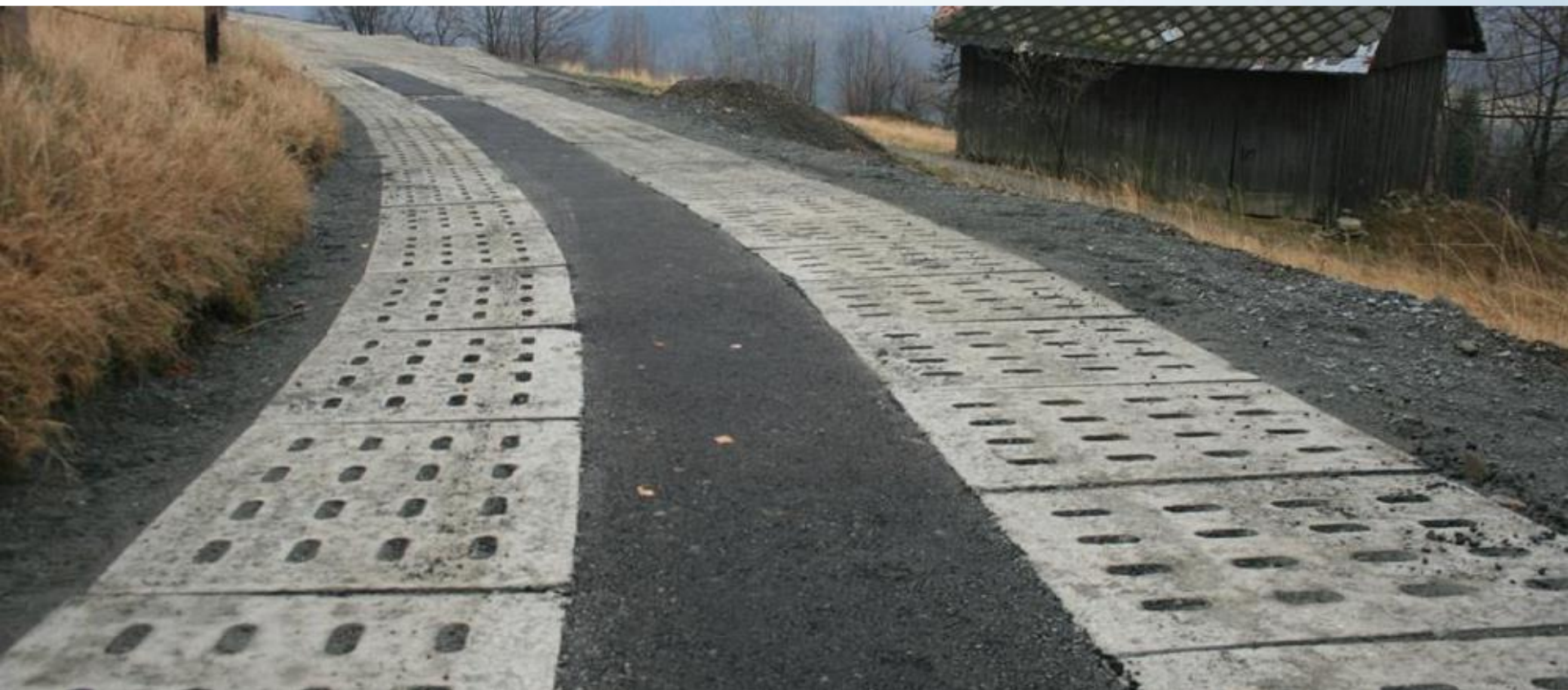
Rys. 20. Nawierzchnia z płyt ażurowych
