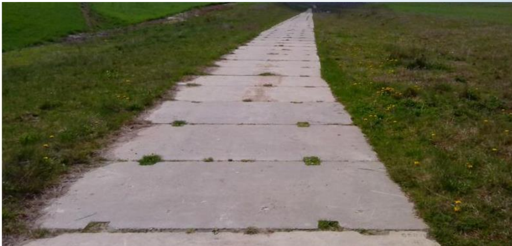
Rys. 99. Nawierzchnia z płyt betonowych MON
