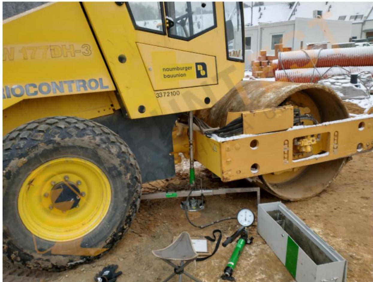
Badanie nośności gruntu płytą VSS.
