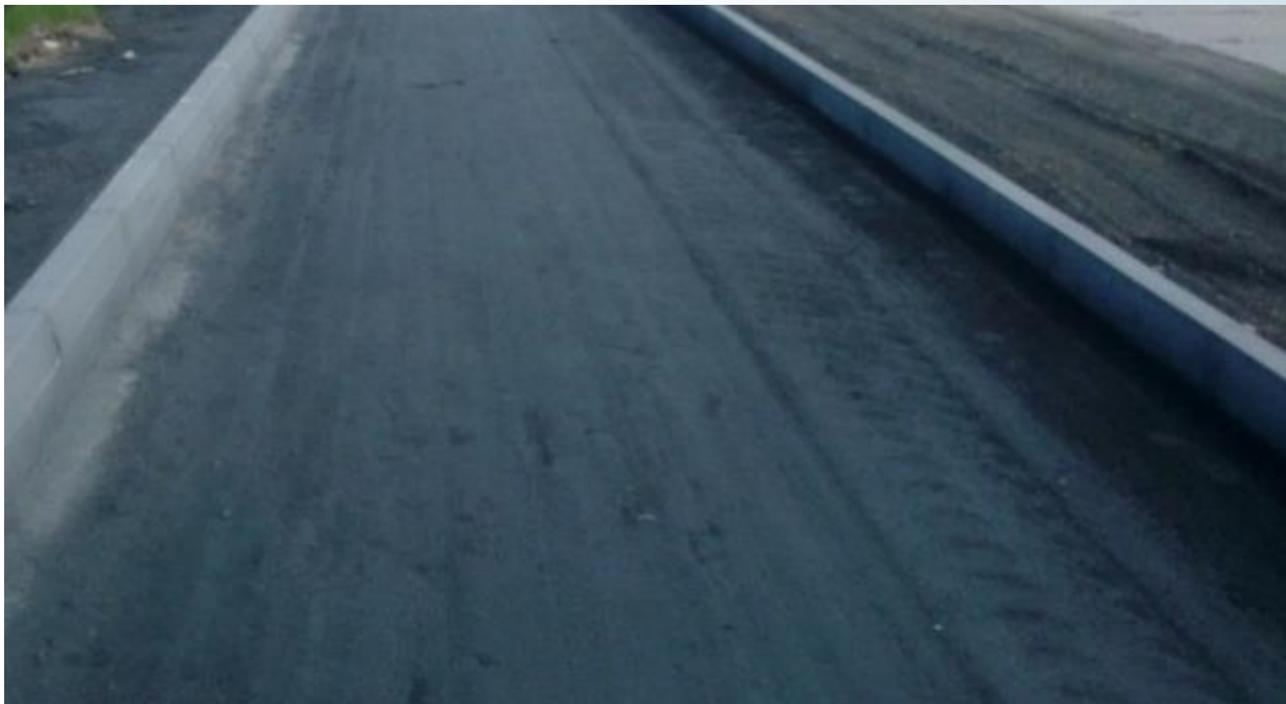
Rys. 9. Podbudowa z kruszywa stabilizowanego popiołem lotnym
