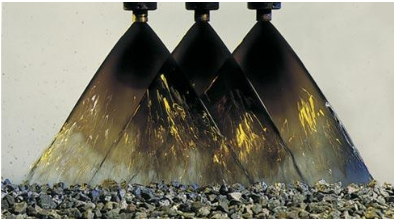
Rys. 31. Spryskiwanie warstwy nawierzchni drogowej emulsją asfaltową
