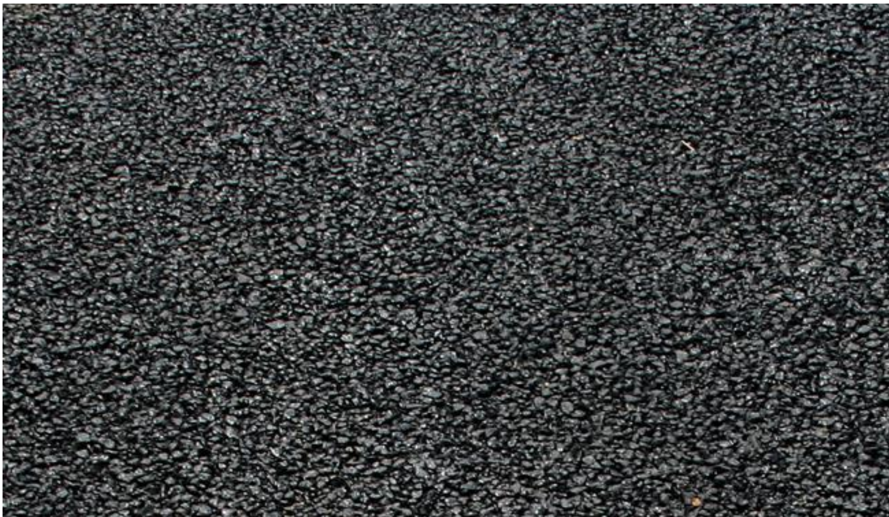
Rys. 15. Tekstura warstwy ścieralnej z BBTM
