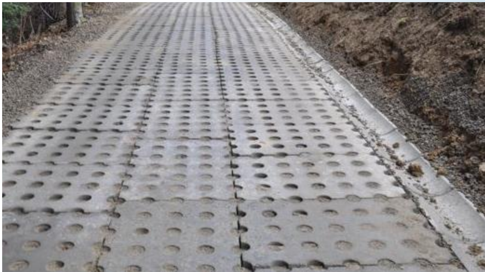
Rys. 22. Nawierzchnia z płyt ażurowych
