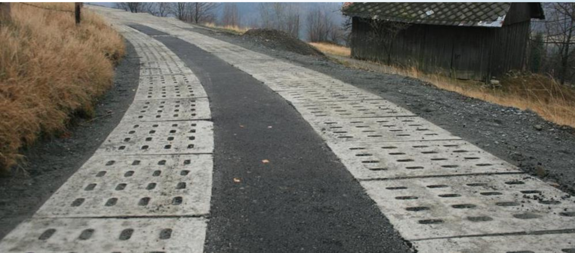
Rys. 20. Nawierzchnia z płyt ażurowych
