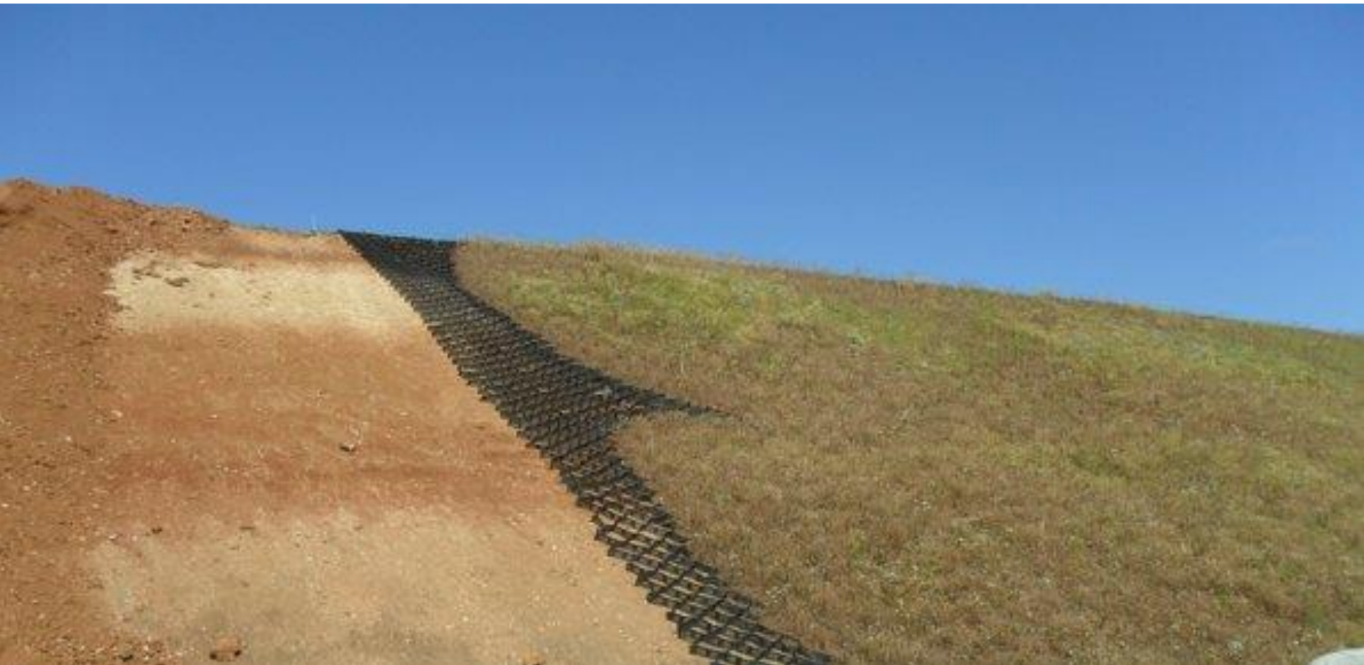
Rys. 44. Wzmocnienie geosiatką skarpy nasypu
