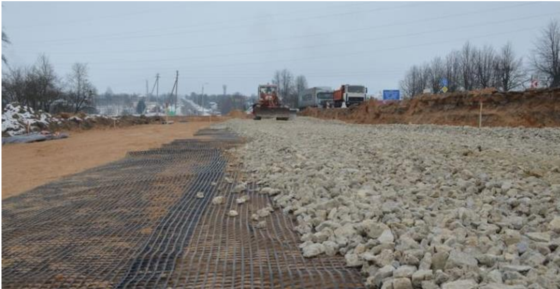
Rys. 42. Zastosowanie geosiatki w podłożu gruntowym
