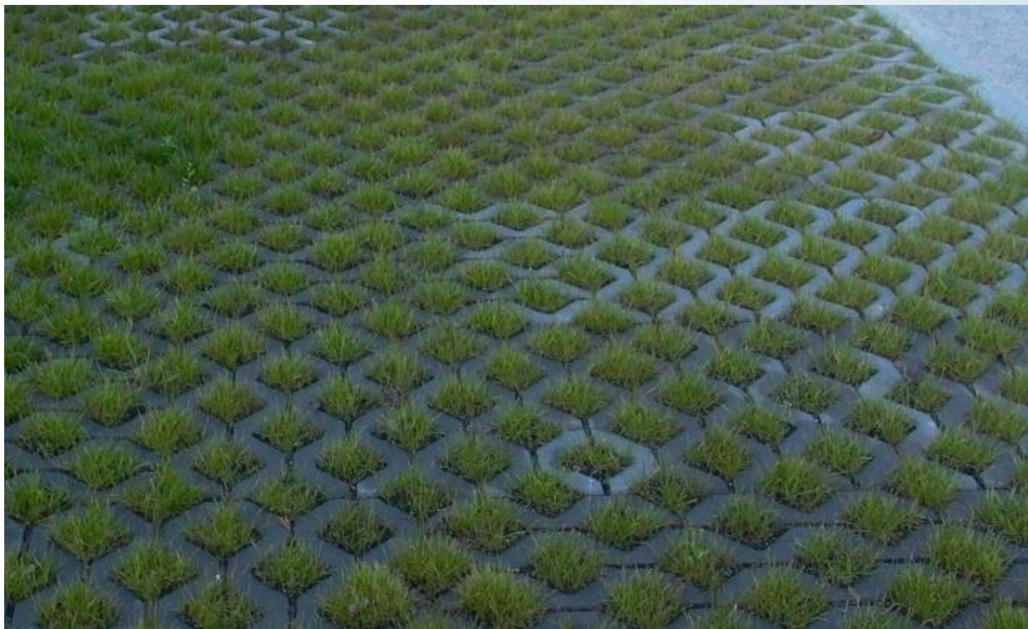
Rys. 18. Nawierzchnia parkingu z płyt ażurowych
