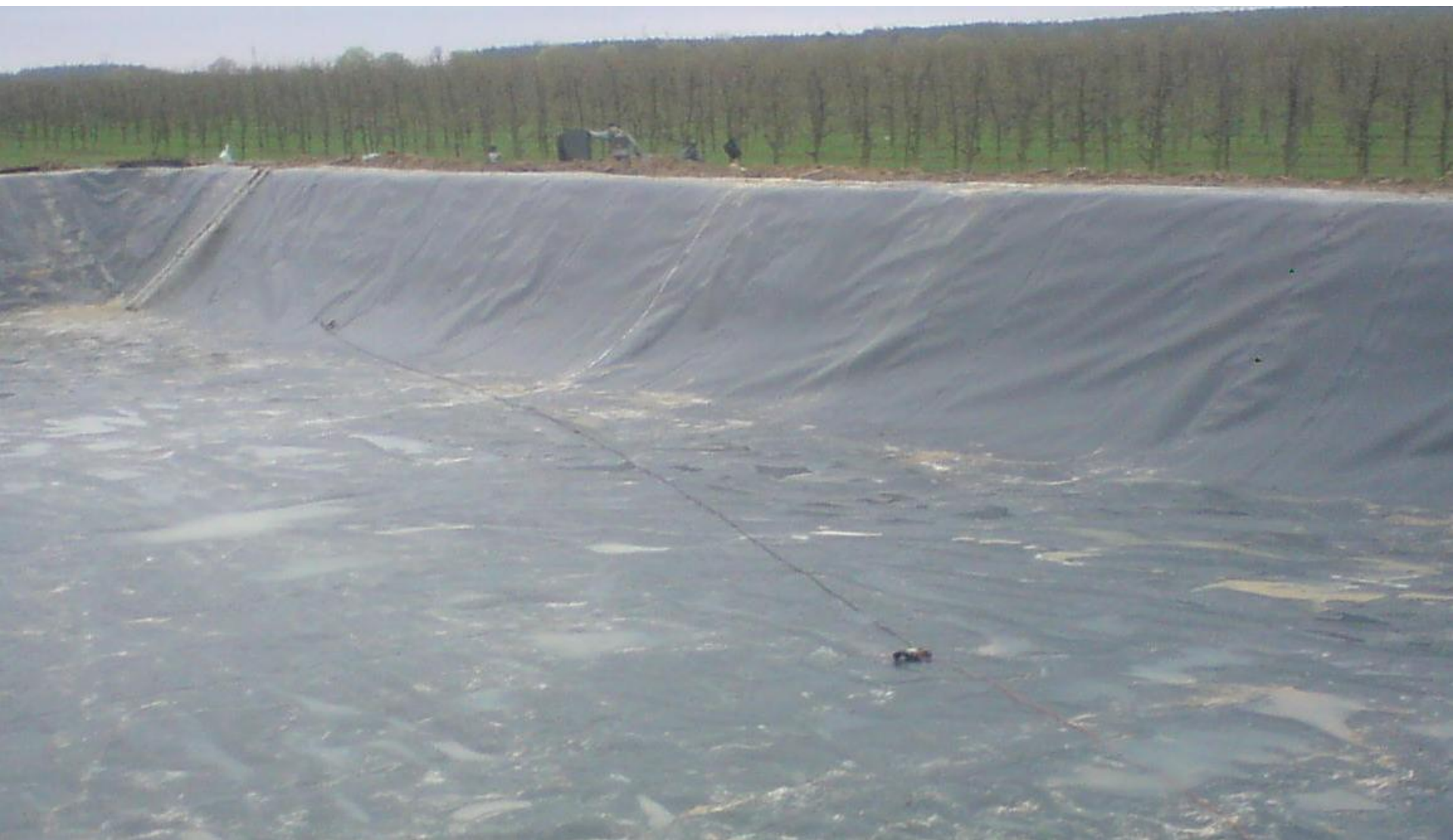
Rys. 43. Geomembrana (hydroizolacja zbiornika wodnego)
