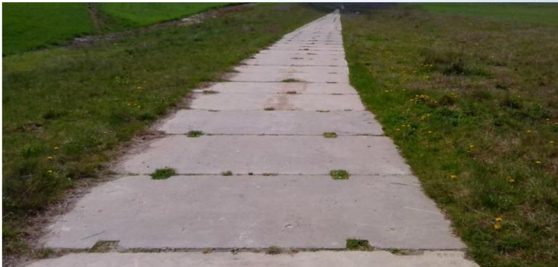
Rys. 99. Nawierzchnia z płyt betonowych MON
