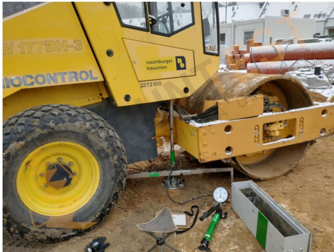
Badanie nośności gruntu płytą VSS.
