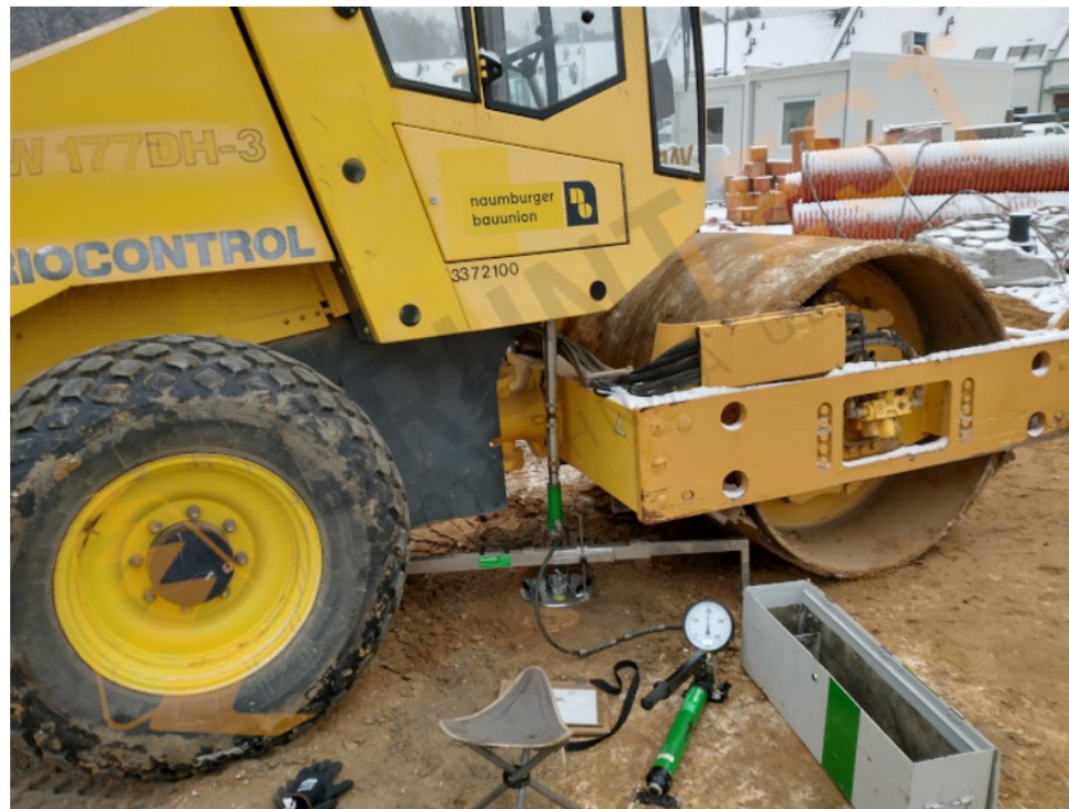
Badanie nośności gruntu płytą VSS.
